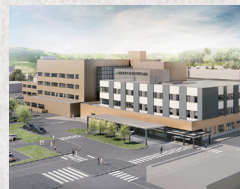
新棟建設中 今年度リニューアルオープン予定
